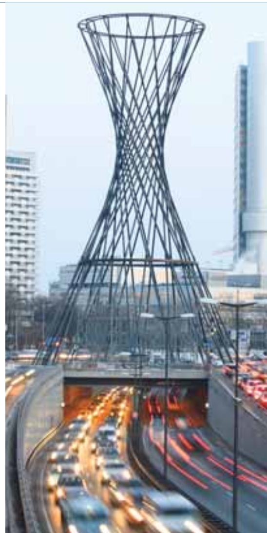
Das 52 Meter hohe Kunstwerk aus Carbonrohren „Mae West“ ist am Münchner Effnerplatz zu bewundern. Bild: cgb Carbon Großbauteile
