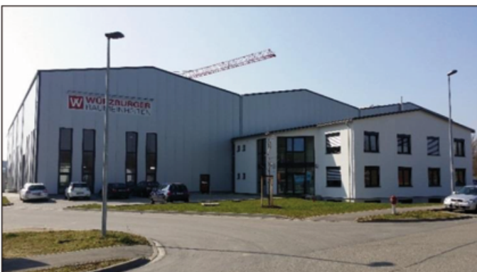
Betriebsgebäude Bad Bellingen - Rheinweiler
