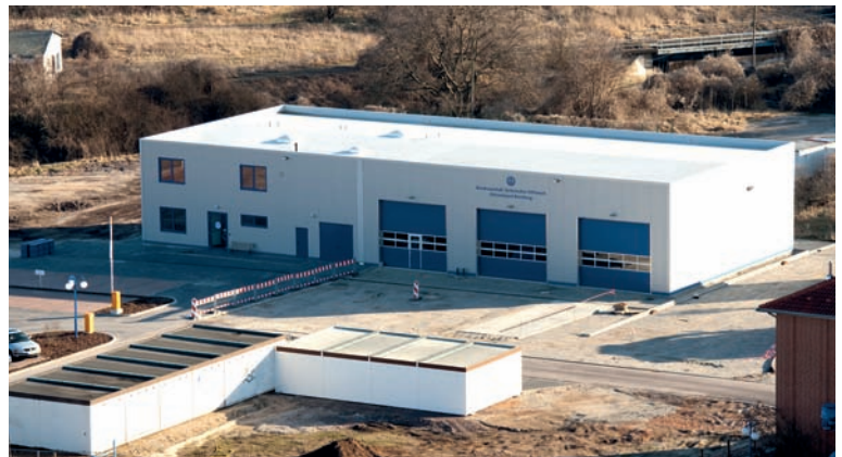
Neubau THW Gebäude Ortsverband Bernburg mit Außenanlagen auf dem Gelände des WZV „Saale-Fuhne-Ziethe“ in Bernburg
