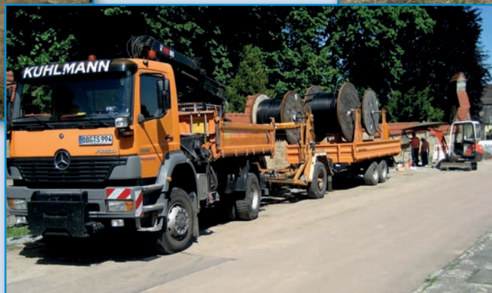
Bernburg, Kabelverlegung in der Ilberstedter Straße
