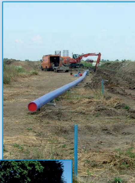
Bernburg, B 6 n, Umverlegung Trinkwasserleitung
