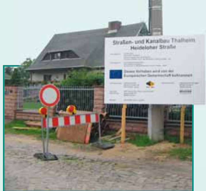
Kanalbau Thalheim, Heideloher Straße
