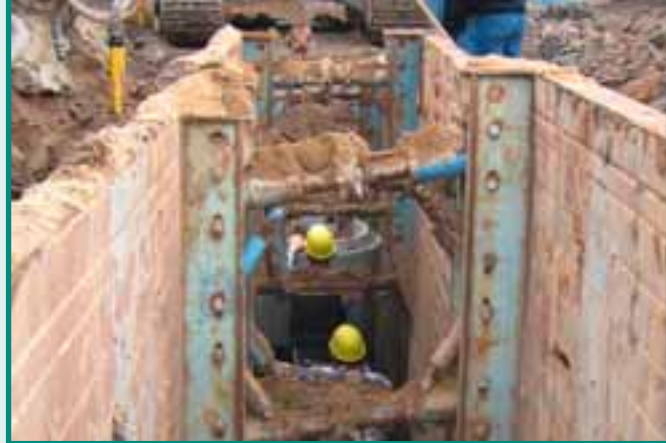
Kanalbau Bitterfeld, Am Gelben Wasser
