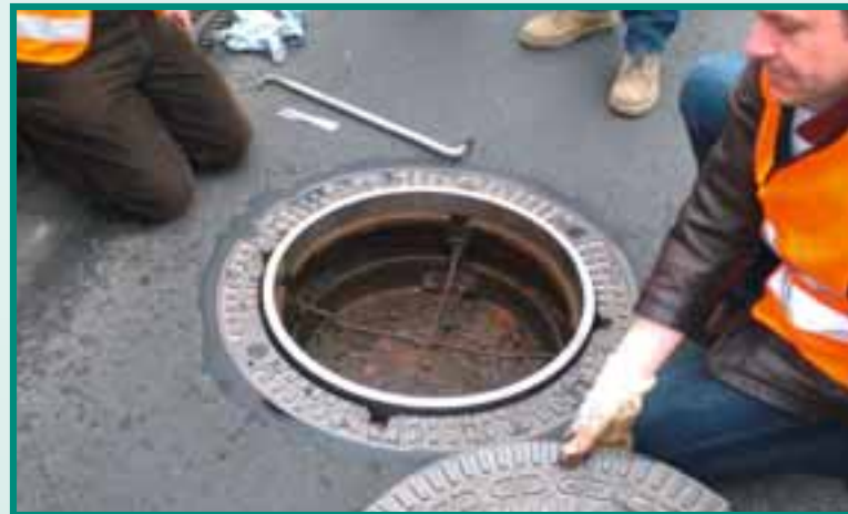
Einbau neue Schachtabdeckung
