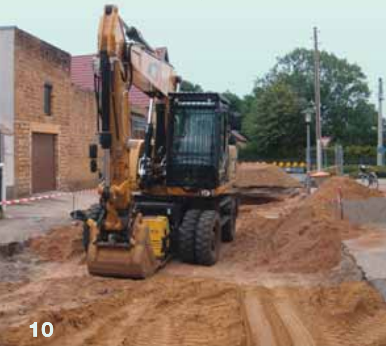
Kanalbau Ramsin, Köckernsche Straße
