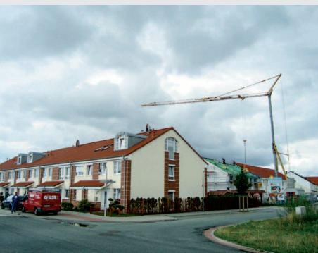
Neubau Hans-Hackmack-Straße Arsten Süd-West
