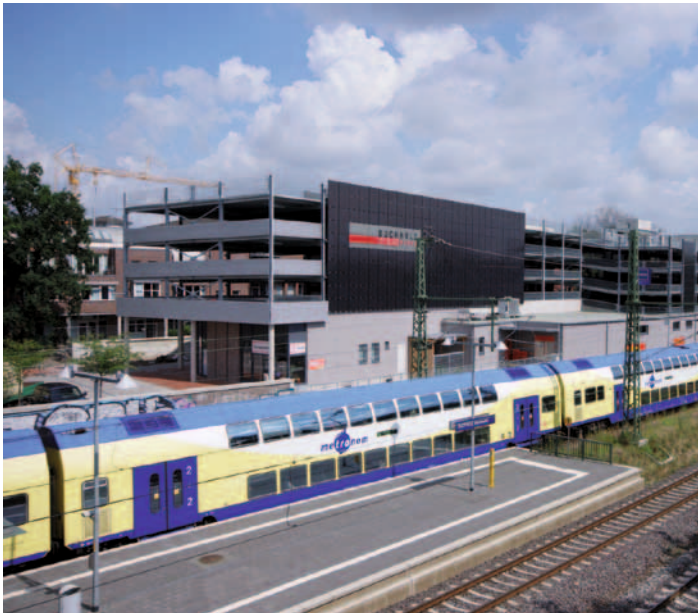
Kabenhof Park- und Geschäftshaus (Ansicht von der Bahnhofseite)
