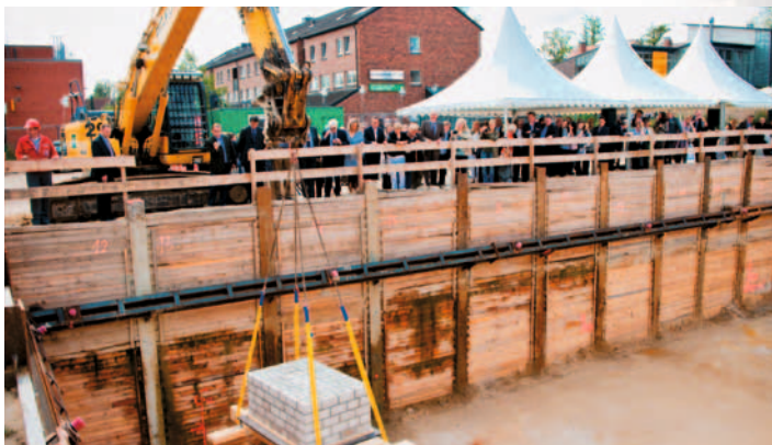
Der Grundstein für die Buchholz Galerie wird gelegt
