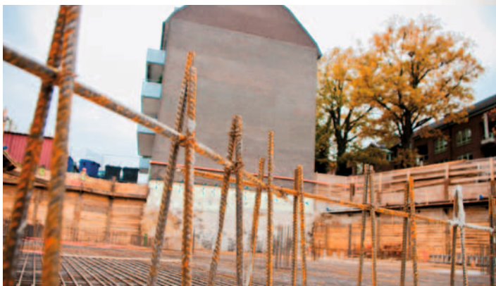
Das Fundament der neuen Volksbank entsteht
