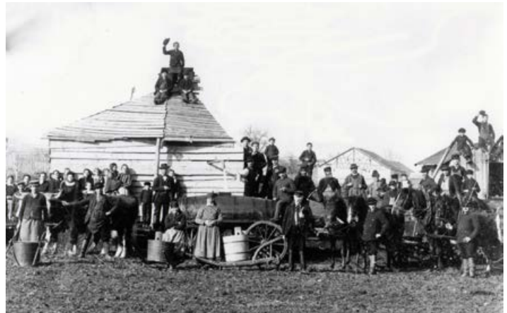
Bau der Wasserleitung 1909 in Tauberfeld
