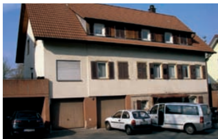
Gebäude vor der Sanierung
