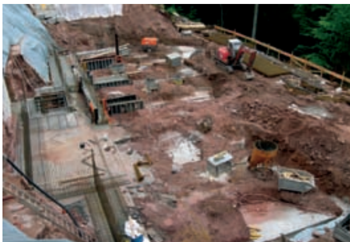
Baustelle in Bad Teinach – Zavelstein
