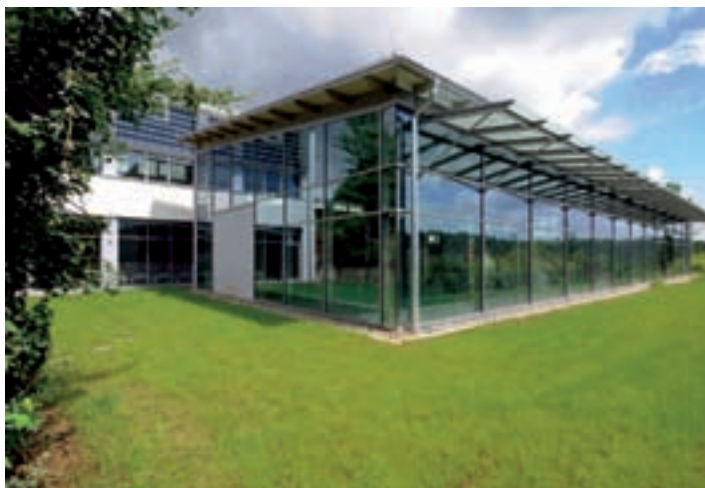
Schwimmhalle Haiterbach von außen
