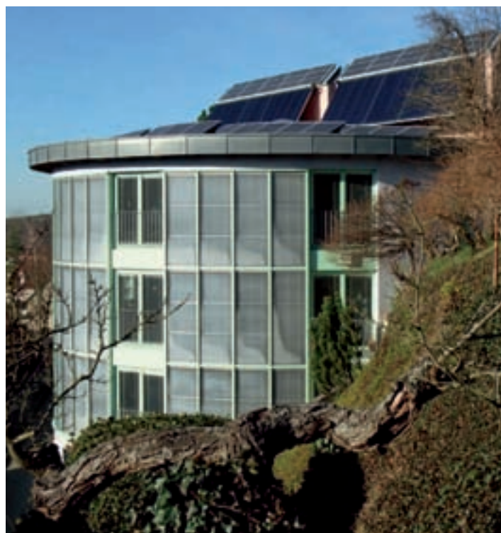
Transparente Wärmedämmung (TWD) auf einer Gebäudefassade
