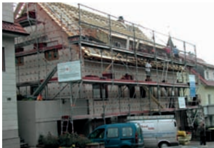
Gebäude in der Sanierung
