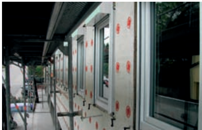
Einbau doppelverglaster Fenster
