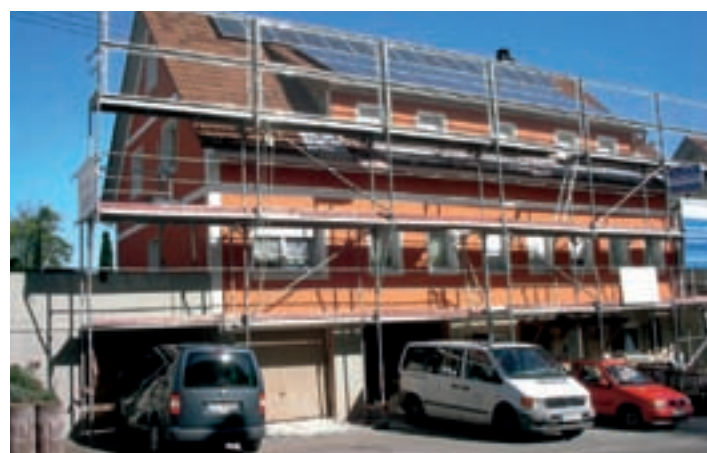
Gebäude kurz vor Fertigstellung der Sanierung
