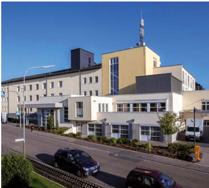
Krankenhaus Dierdorf mit operativen Abteilungen
