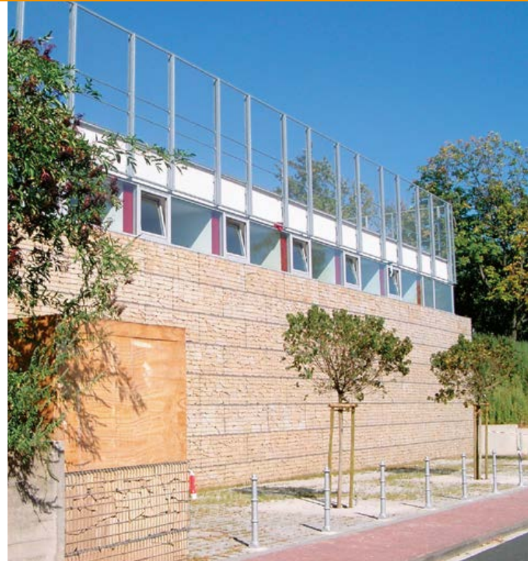
Turnhalle Schule am Hang
