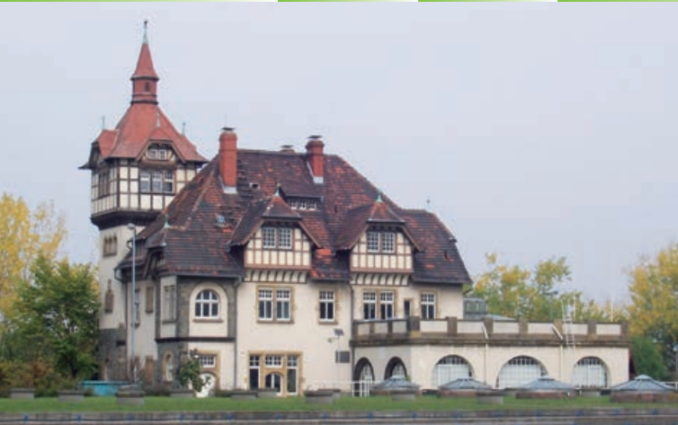
Altes Betriebsgebäude Abwasseranlage in Niederrad
