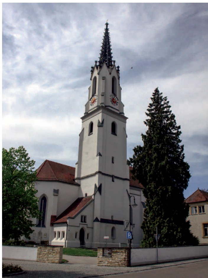
Kath. Pfarrkirche Mariä Aufnahme in den Himmel
