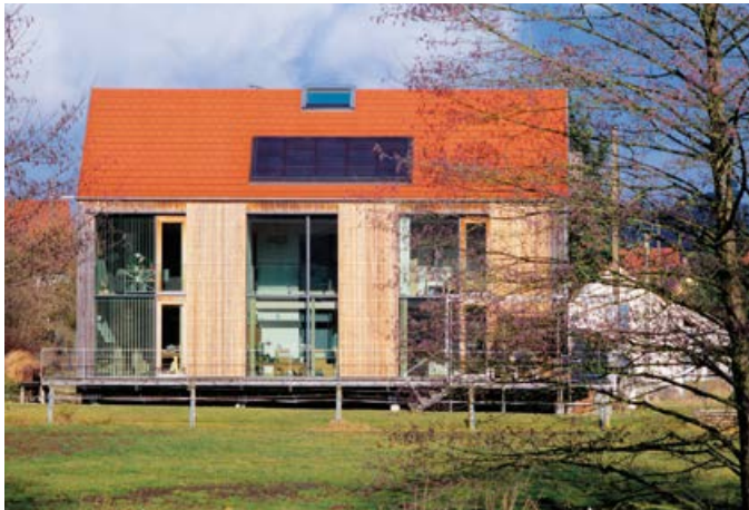
Passivhaus aus Glöttweng. Südseite mit großem Fensterflächenanteil.
