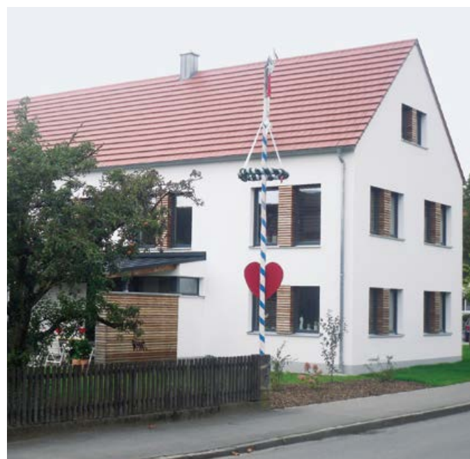
Ein gelungener Ersatzbau aus Münsterhausen
