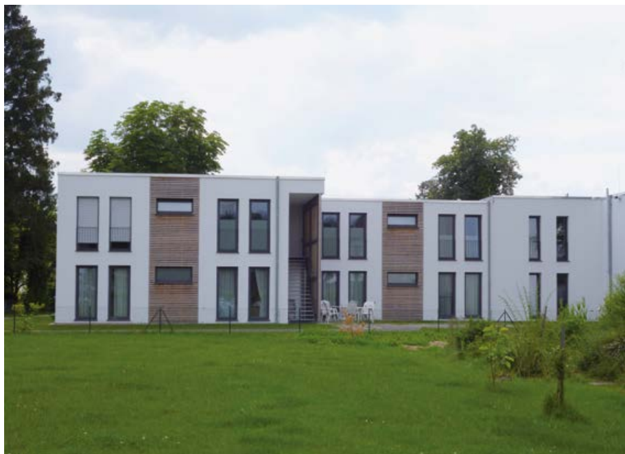
Wohnheim in Thannhausen
