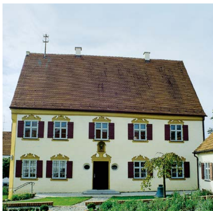
Sanierter Pfarrhof in Winzer
