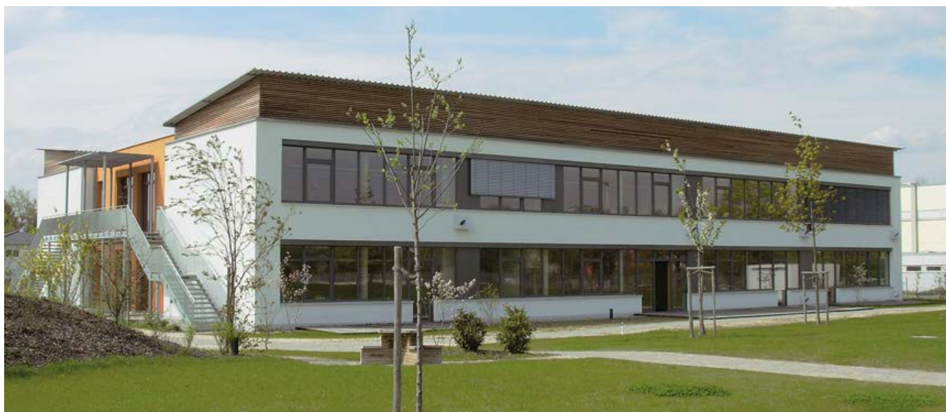
In Passivhausweise errichtete Grundschule in Günzburg
