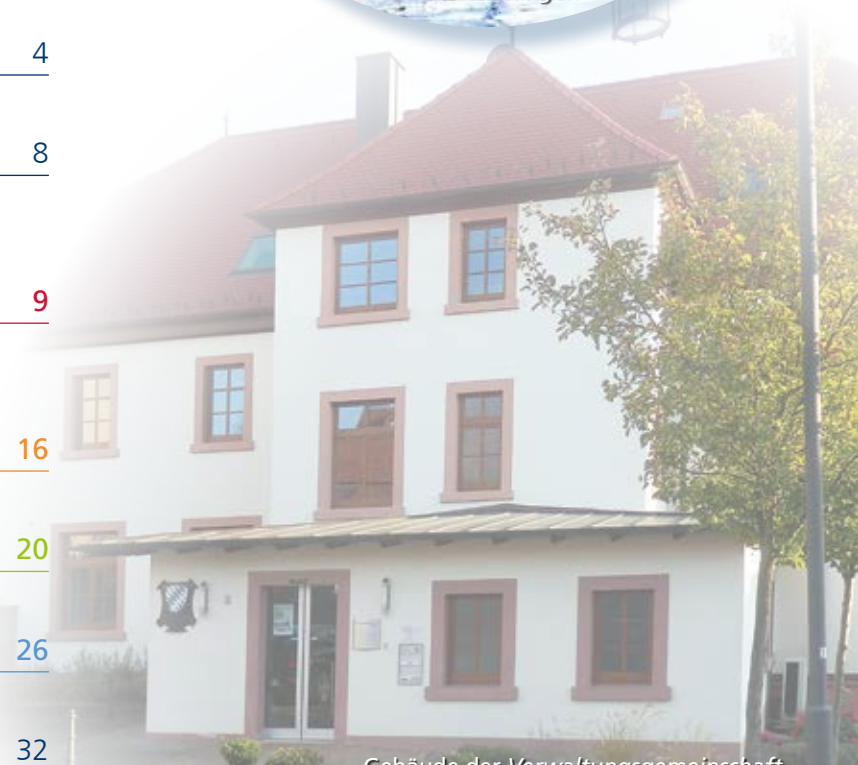
Gebäude der Verwaltungsgemeinschaft
