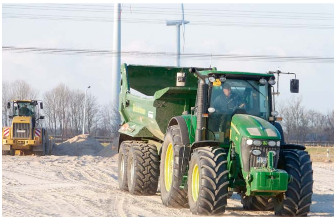
Bauarbeiten im JadeWeserPark
