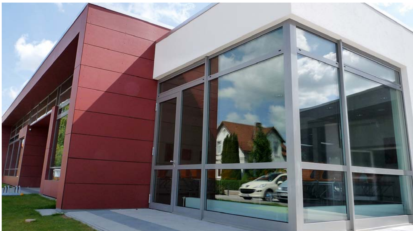
Dieser Mensa- und Büchereianbau für die Haupt- und Realschule Zetel ist für seine gelungene Architektur ausgezeichnet worden.
