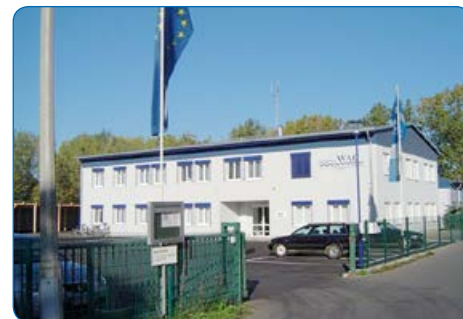
Verwaltungsgebäude des WAC neu – 2006
