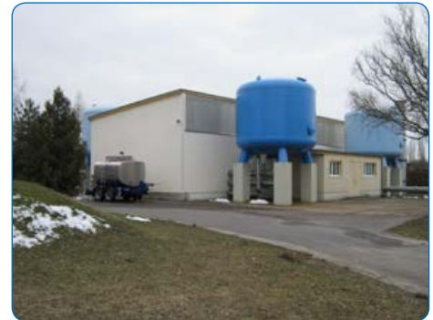
Wasserwerk Lübbenau/Spreewald Filter 5 nach Sanierung – 2012
