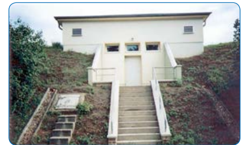
Wasserwerk Lübbenau/Spreewald Reinwasserbehälter neu – 2002
