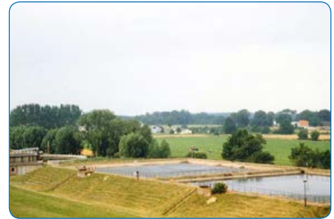
Kläranlage Lübbenau/Spreewald alt
