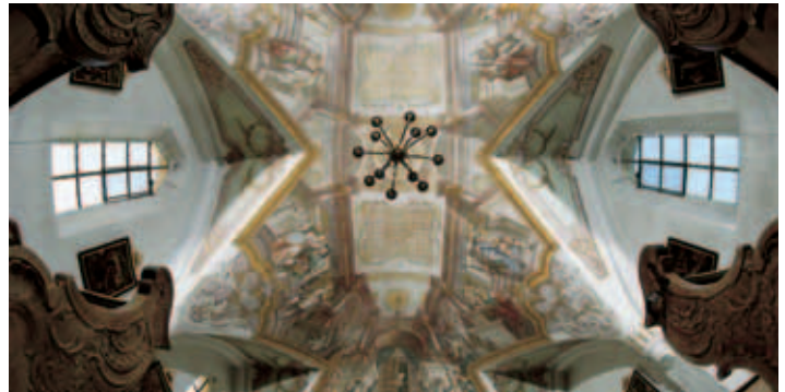
Gewölbe der Alzgerner Pfarrkirche St. Mariä Himmelfahrt
