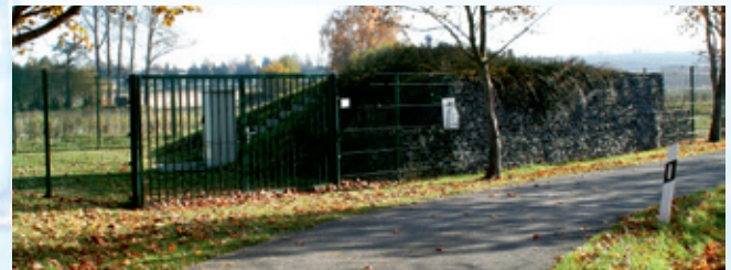
Foto: ZAL, Tiefbrunnen WW Merlach
