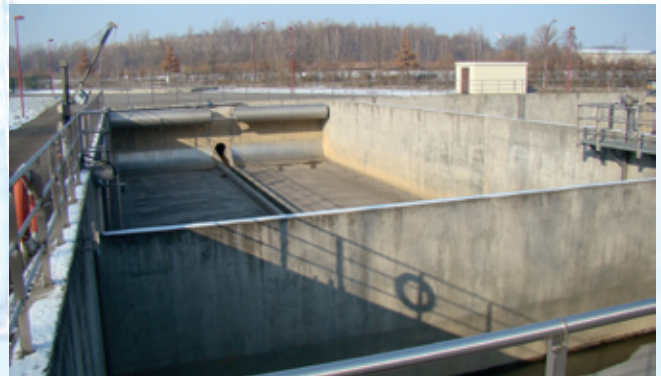
Foto: ZAL, Regenrückhaltebecken Rositz, Gewerbegebiet
