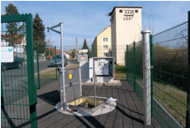
Foto: ZAL AWPS Windischleuba, Luckaer Straße
