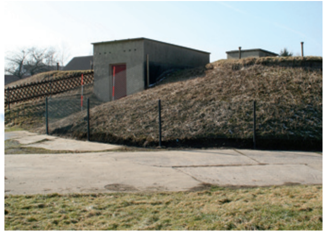
Foto: ZAL, Löschwasserspeicher Gemeinde Nobitz, OT Wilchwitz
