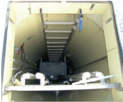
Foto: ZAL, AWPS Windischleuba, Luckaer Straße
