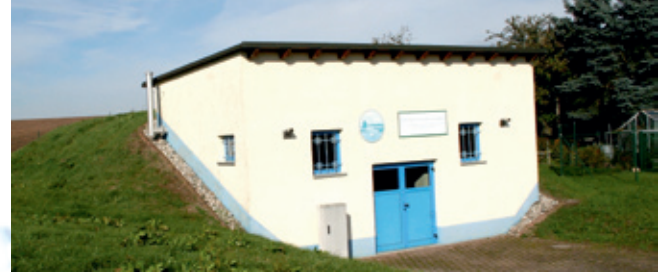
Foto: ZAL, Behälteranlage und Pumpstation Ziegelheim
