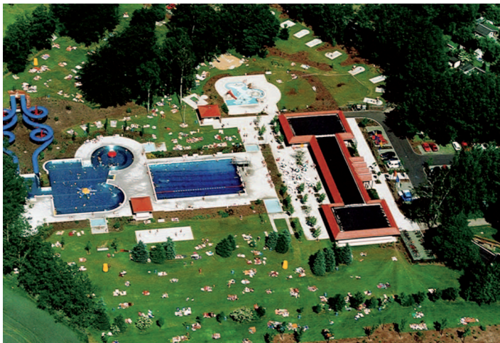
Stadtbad mit Solaranlage
