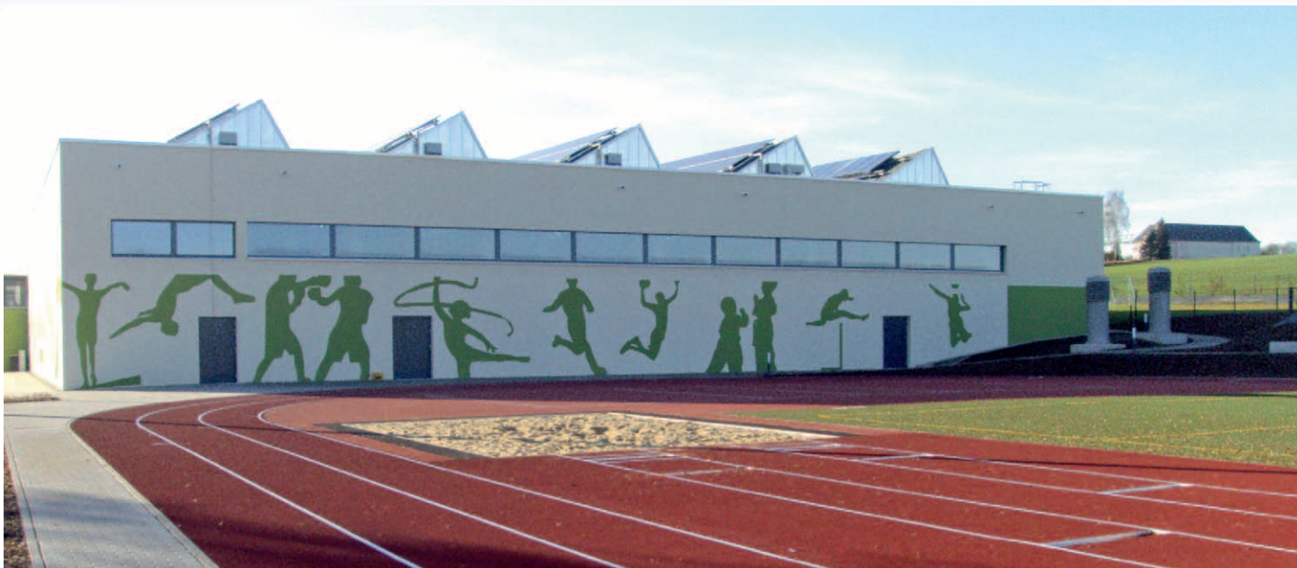
Neue Sporthalle mit Solaranlagen
