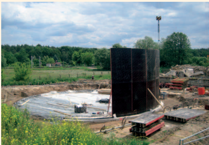
Kläranlage Tangerhütte Schlamm-speicher im Bau
