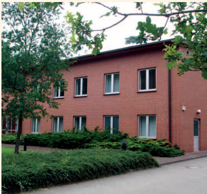
Wasserwerk Osterburg Betriebsgebäude
