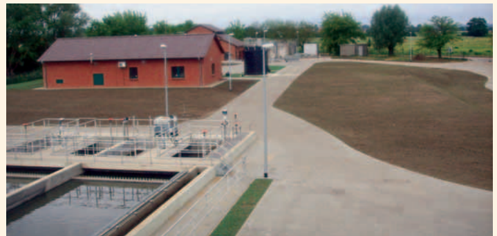
Kläranlage Tangerhütte Abschluss
