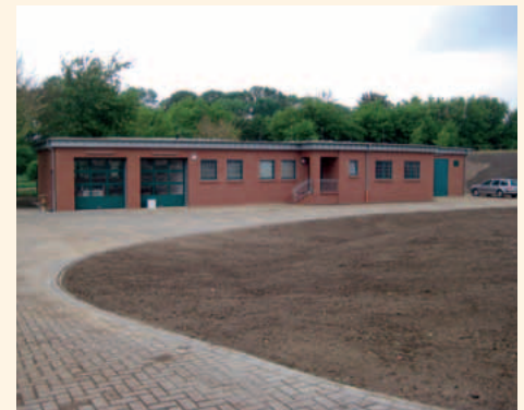
Kläranlage Tangerhütte Betriebsgebäude neu
