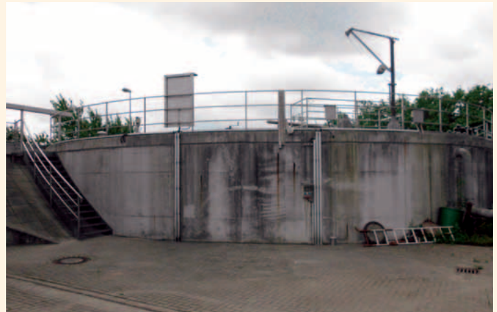
Kläranlage Tangerhütte Ausgleichsbecken
