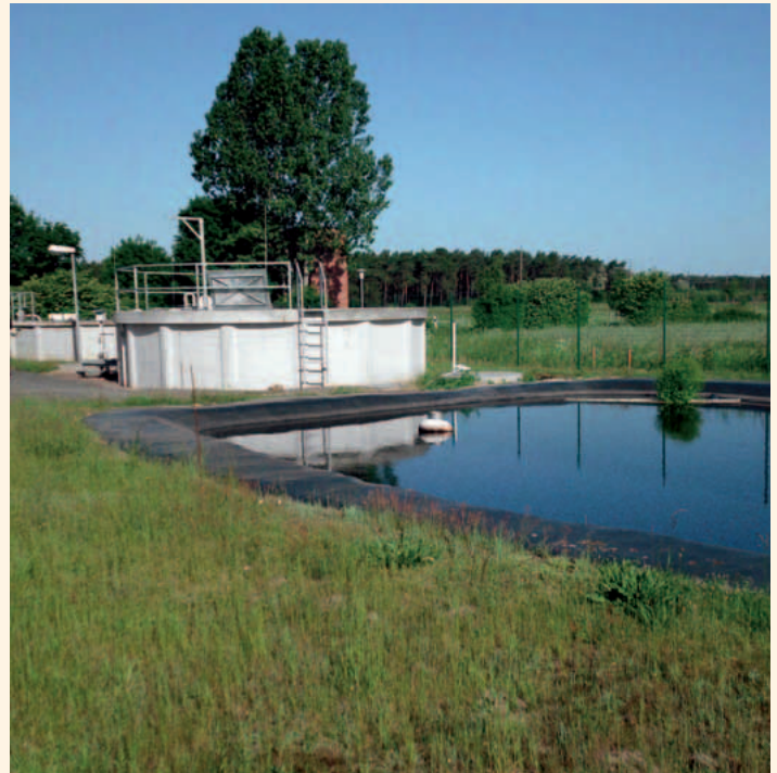
Kläranlage Bittkau Schönungsteich
