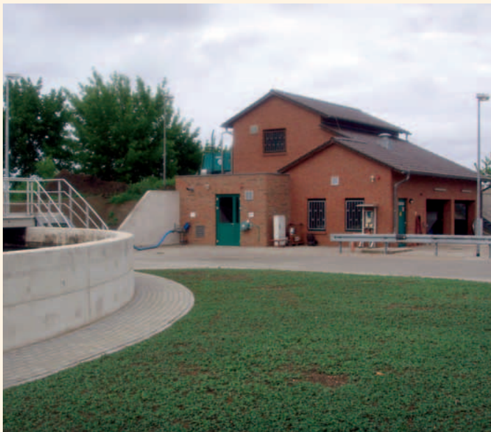
Kläranlage Tangerhütte – Betriebsgebäude mechanische Vorreinigung
