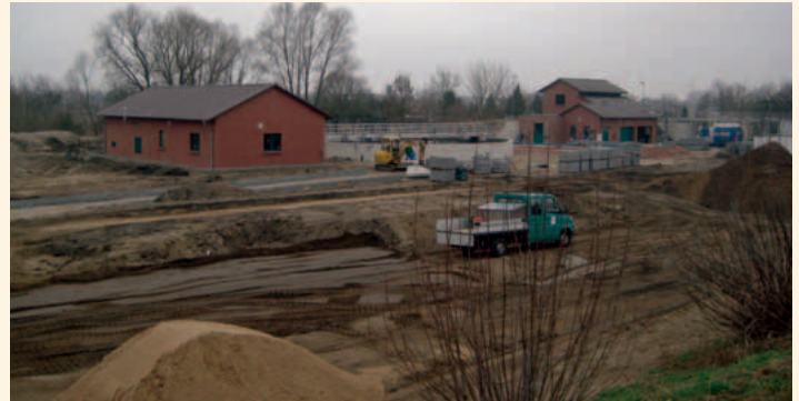
Kläranlage Tangerhütte Überblick Baustelle
