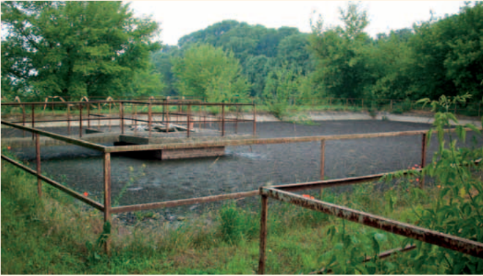
Kläranlage Tangerhütte Schlamm Speicher alt
