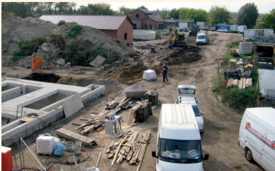
Kläranlage Tangerhütte Baustelle – Nachklär- und Selektorbecken
