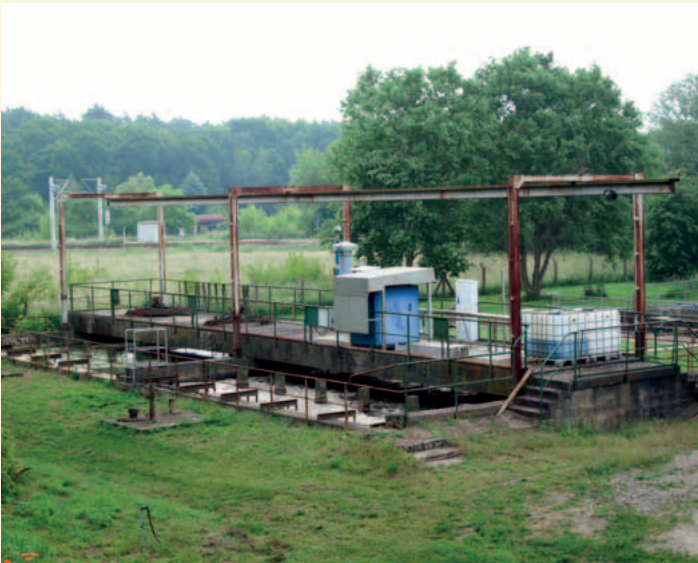
Kläranlage Tangerhütte Belebungsbecken alt
