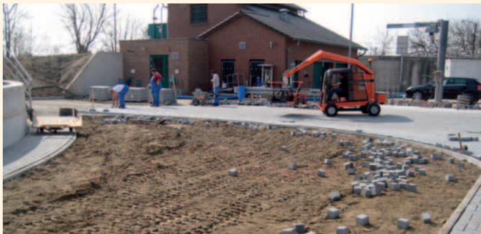
Kläranlage Tangerhütte Pflasterarbeiten
