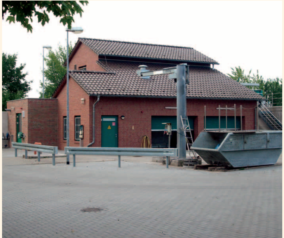
Kläranlage Tangerhütte Mechanische Vorreinigung
