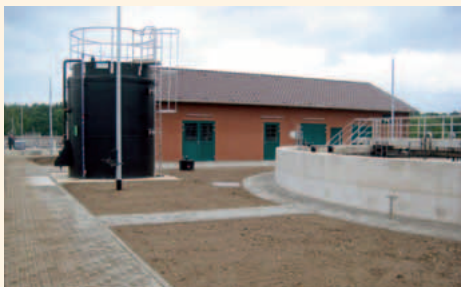
Kläranlage Tangerhütte Chemische Phosphatfällung
