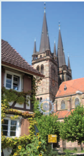
Ecke Laufer Straße / Friedhofstraße
