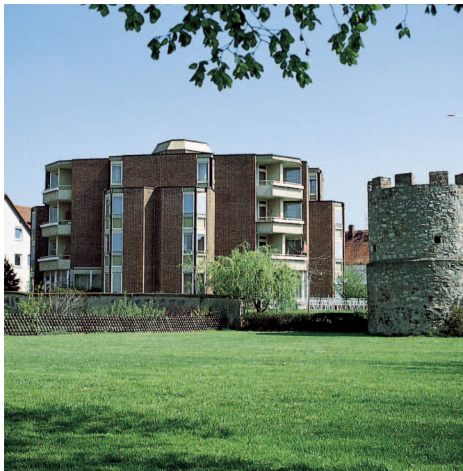
Altenwohnheim Grabenstraße mit Turm der Bätekammer“
