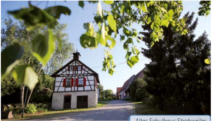
Altes Schulhaus Strohweiler
