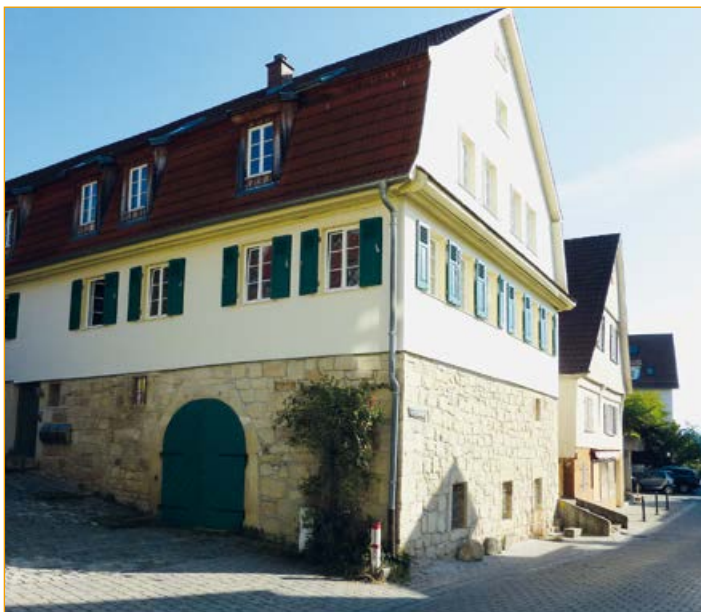
Denkmalgeschütztes Gebäude nach der Modernisierung
