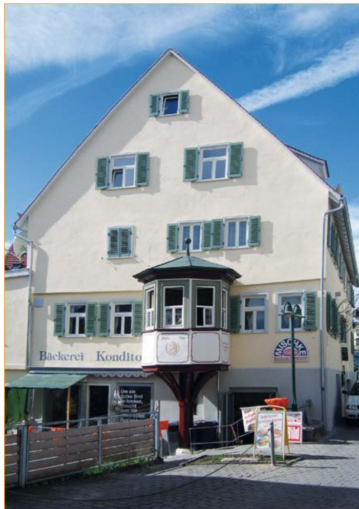
Denkmalgeschütztes Gebäude nach der Modernisierung
