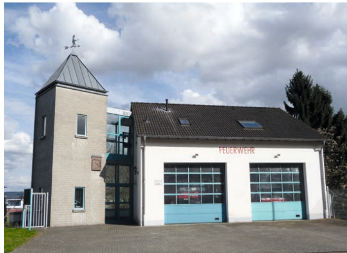
Bild Nr. 7: das neue Feuerwehrgerätehaus vom Löschzug Euren!
