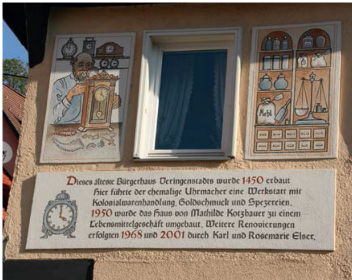
Ackerbürgerhaus mit Hausinschrift
