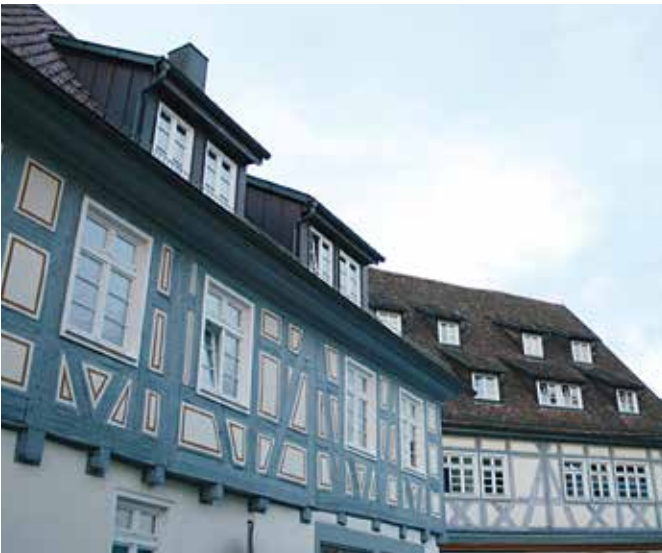
Fachwerkgebäude in der Zwerch- und in der Scheuerngasse. Im rechten Gebäude ist das städtische Gebäudemanagement untergebracht.
