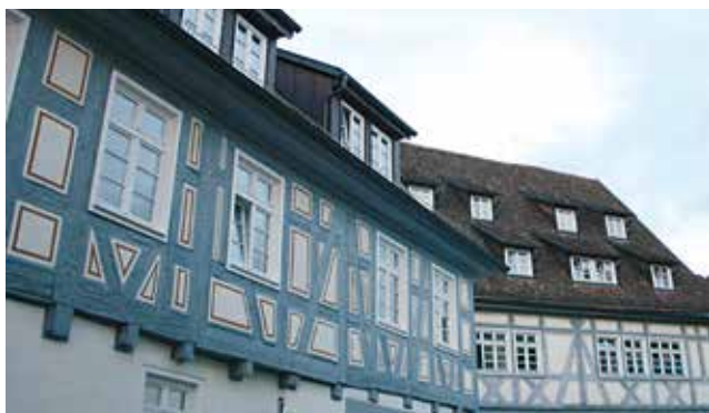
Fachwerkgebäude in der Zwerch- und in der Scheuerngasse. Im rechten Gebäude ist das städtische Gebäudemanagement untergebracht.
