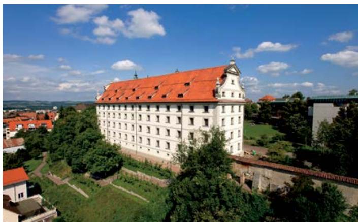
Im ehemaligen Fruchtkasten ist heute die Hochschulbibliothek untergebracht.
