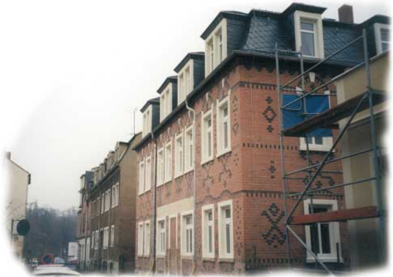
Markstraße 3 – Modernisierung und Instandsetzung
