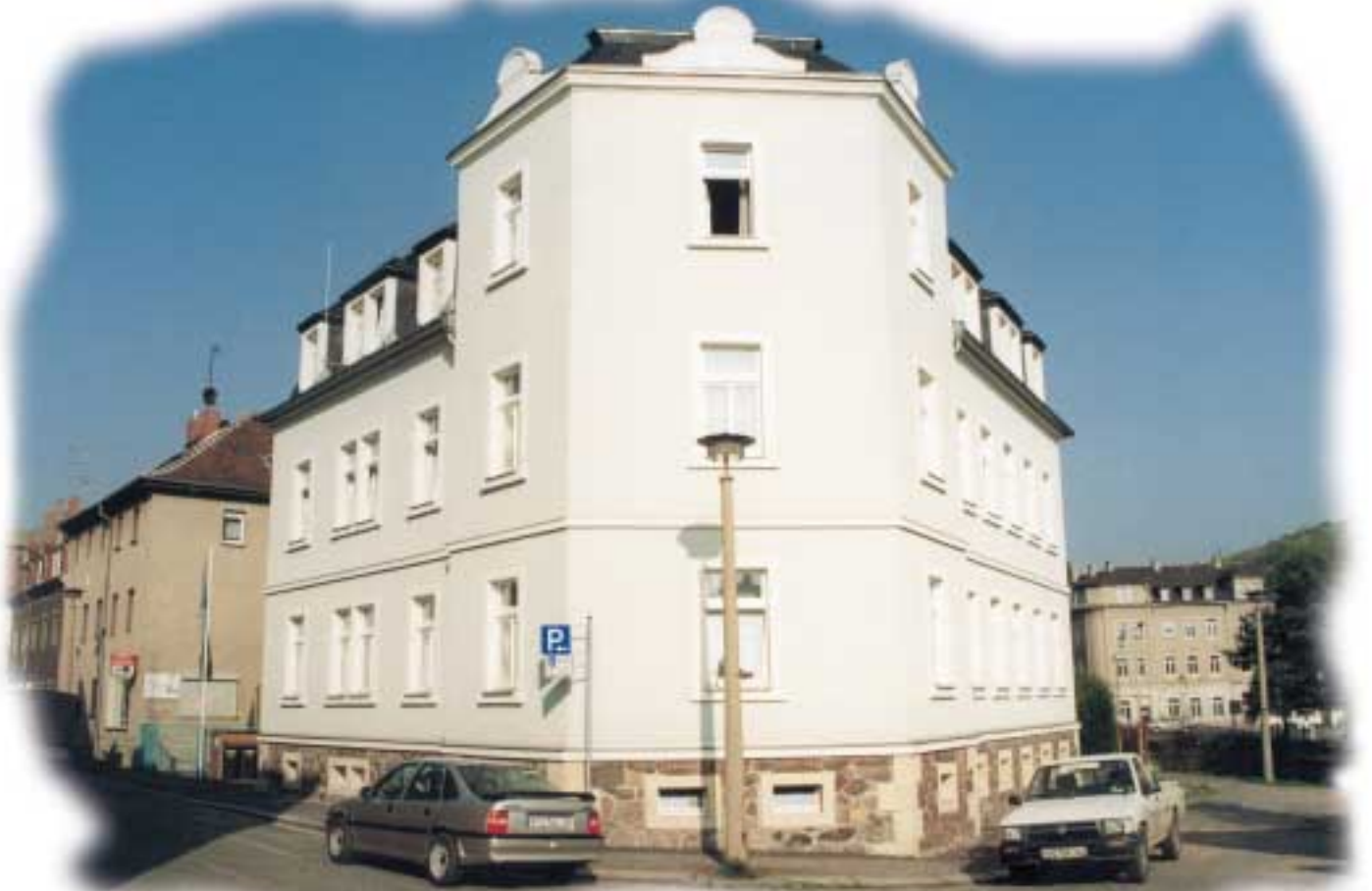
Neue Straße 9 – Förderung einer Komplettsanierung
