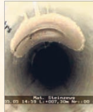
Bild 19: Stutzen einer Hausanschlusbleitung nach der Sanierung
