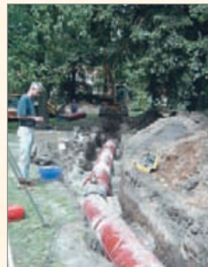
Bild 8: Verlegung Hauptsammler im Stadtpark in Delitzsch
