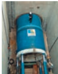
Rohrvortrieb DA 3800 Leipzig-Connewitz
