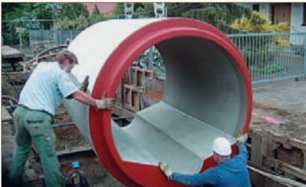
Bild 12: Staukanal DN 1800 mit Trockenwetterrinne, Erzberger Straße
