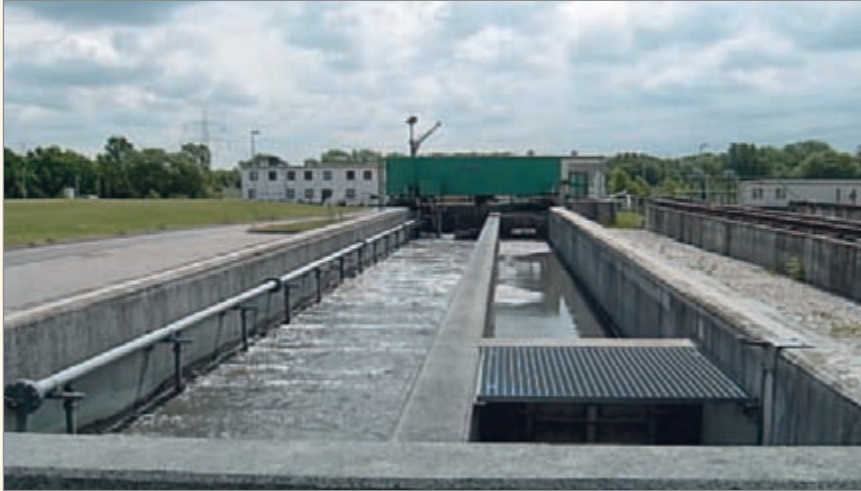
Bild 22: Belüfteter Sandfang
