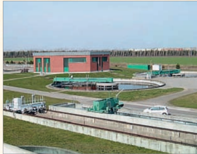
Bild 20: Belüfteter Sandfang, Nachklärbecken
