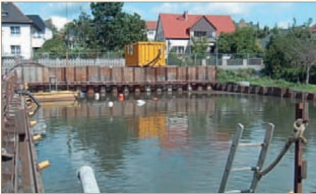
Bild 10, 11: Mischwasserentlastungsbauwerk, Erzberger Straße
