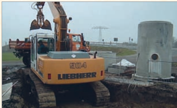
Bild 7: Neubau der Schmutzwasserleitung in Zschepan
