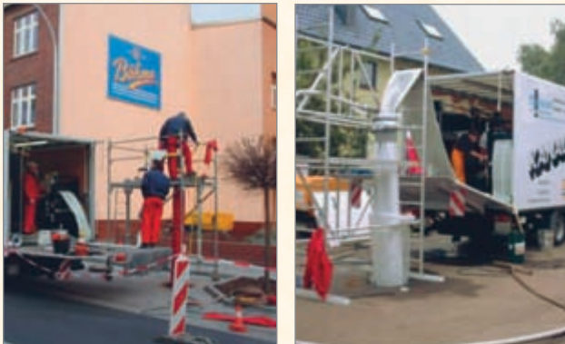
Bild 16: Sanierung durch Linerverfahren in Delitzsch
