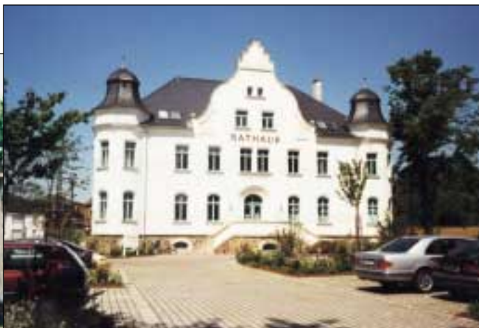
Rathaus Rackwitz vor und nach der Sanierung
