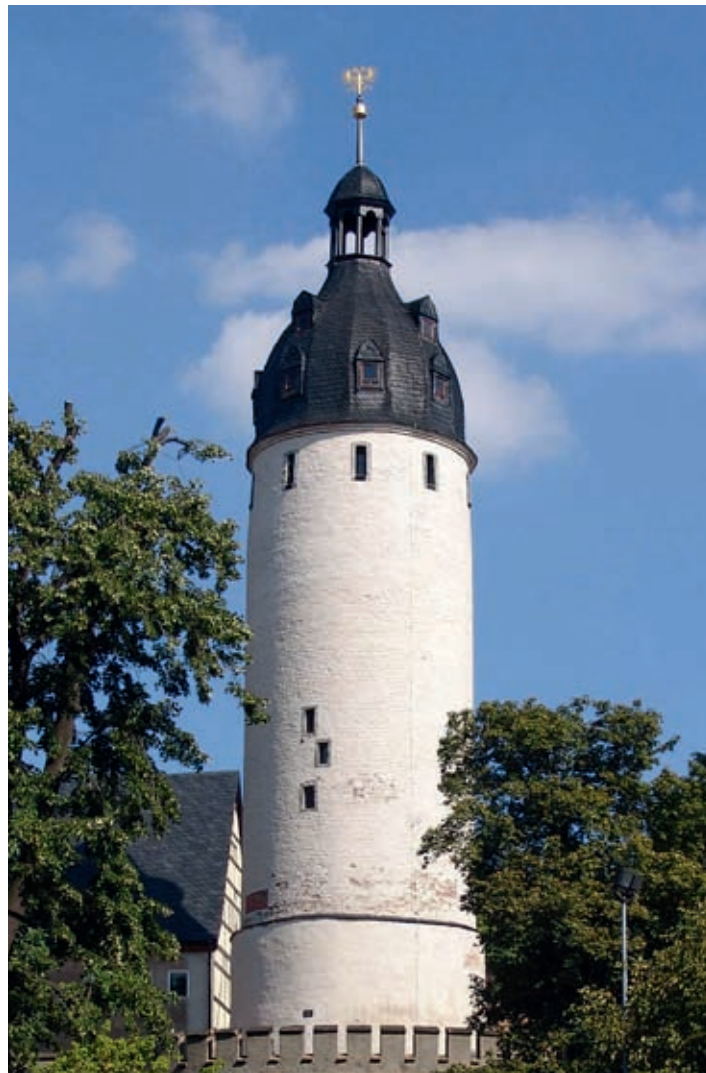
Hausmannsturm, Bildquelle: Stadt Altenburg, Pressestelle
