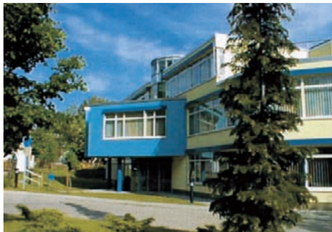
Kundendienst- und Verwaltungszentrum in Döbeln, erbaut 1999/2000
