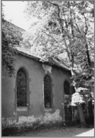
Kirche in Micheln vor der Sanierung
