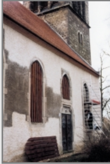
Kirche in Micheln nach der Reparatur des Dachstuhles, Erneuerung der Dacheindeckung, Reparatur des Putzes und jetzt Erneuerung der Fenster
