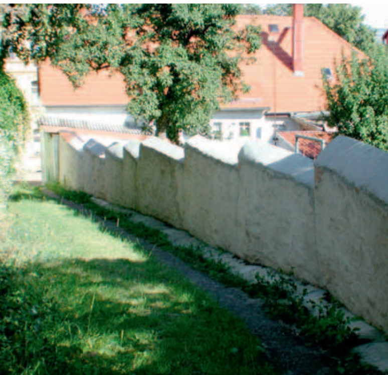
Bruchsteinmauer
