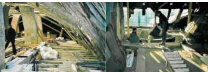
Dachinstandsetzung · Roof repairs
