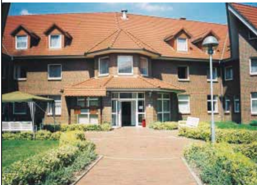
Vorderansicht Neubau Haus „Neue Mühle“ (Pflegeeinrichtung)
