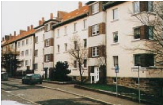
Zeitz, Senefelder Straße 2-12 Sanierung und Modernisierung 1995, ältester Baubestand der Wohnbau Theißen e.G.
