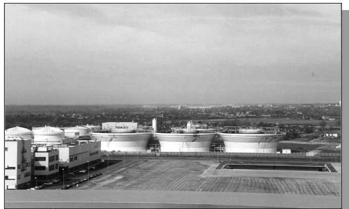
Blick auf Wolfen – im Vordergrund das neue Klärwerk
