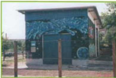
Komplettsanierung einer Abwasserpumpstation mit eigenwilliger Fassade
