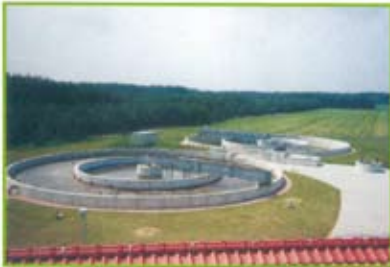
Neubau einer Kläranlage
