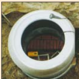
Kanalzugang über einen Kontrollschacht
