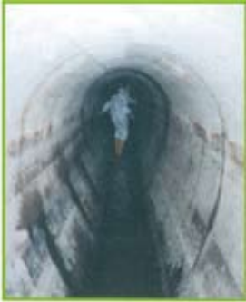
Sanierung eines begehbaren Mischwasserkanals
