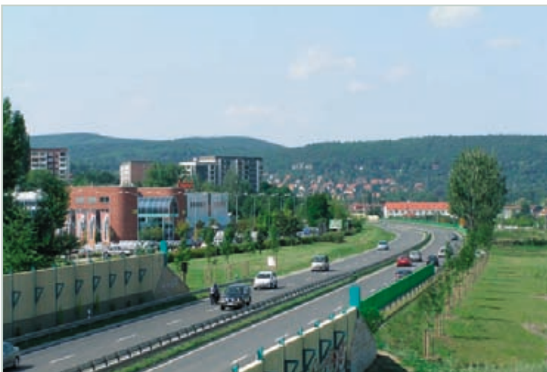
Abschnitt der Ortsumgehungsstraße von Rudolstadt-Schwarza.
