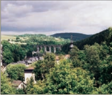
Gemeinde Lichte mit Piesau-Viadukt und Kirche
