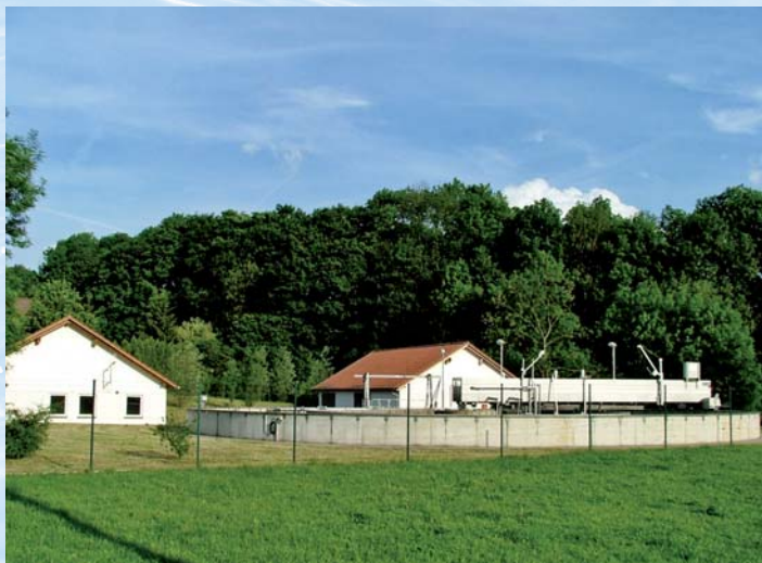
Foto: Zweckverband; Kläranlage Triptis
