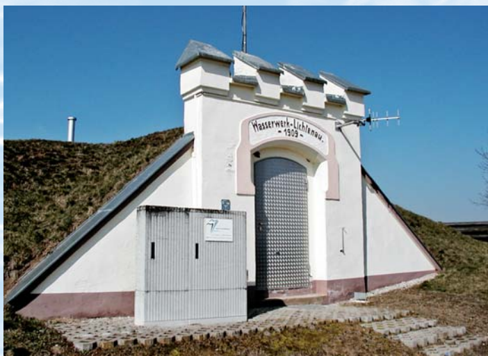
Hochbehälter Lichtenau (2 x 60 m 3 )
