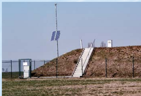
Foto: ZV, Hochbehälter für die Gemeinde Schmorda
