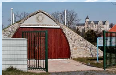
Trinkwasser-Hochbehälter „Platte“ in Ranis, 2 x 150 m 3
