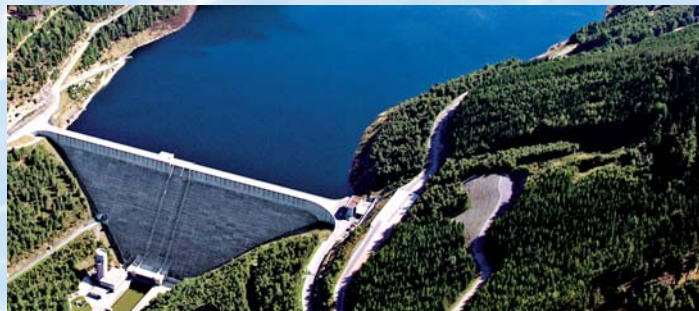
Luftbild der Talsperre Leibis/Lichte (Quelle: TFW)
