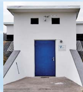
Foto: Zweckverband Kospoda, Hochbehälter im Ortsteil Burgwitz
