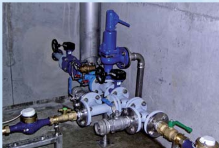
Foto: ZV, Übergabeschacht bei Dreba (Innenansicht)
