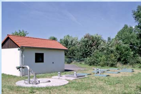
Foto: ZV, Kläranlage der Gemeinde Nimritz
