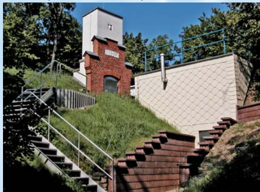
Hochbehälter „Preißnitzberg“ in Ranis, 2 x 100 m 3
