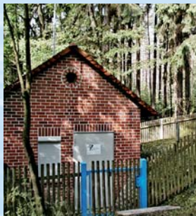
Foto: Zweckverband Neustadt an der Orla, Druck- erhöhungsanlage Waldfrieden
