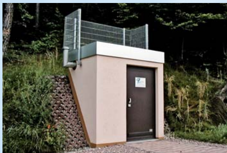
Foto: ZV, Druckerhöhungsanlage in Langendembach
