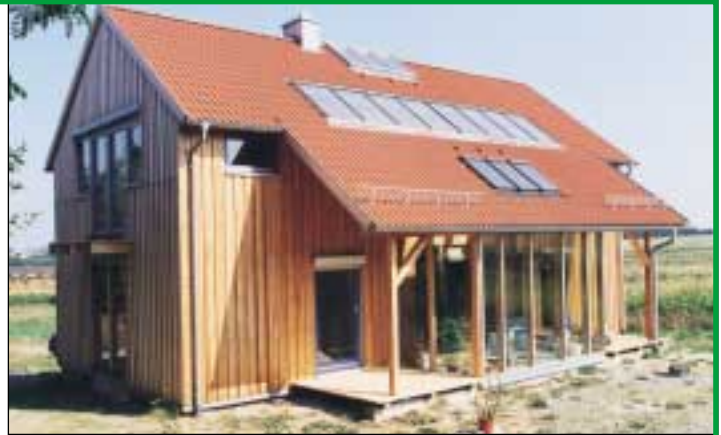
Holzrahmenbau, Wohnhaus Familie Wandsleb in Lemnitz (Thüringer Architekturpreis 1997)
