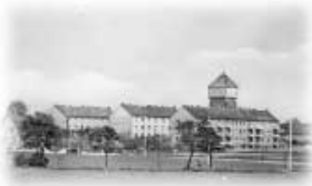
AWG – Häuserblocks, erbaut 1961 (um 1975)
