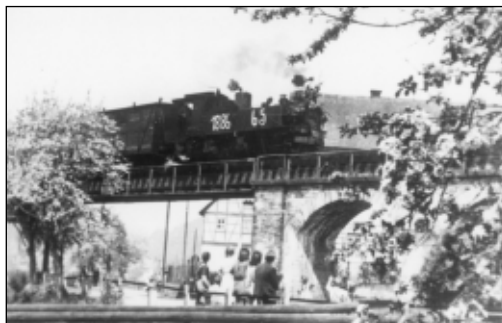
Bahnbrücke in Mülsen St. Niclas (aus Sicht von Ortmannsdorf kommend)
