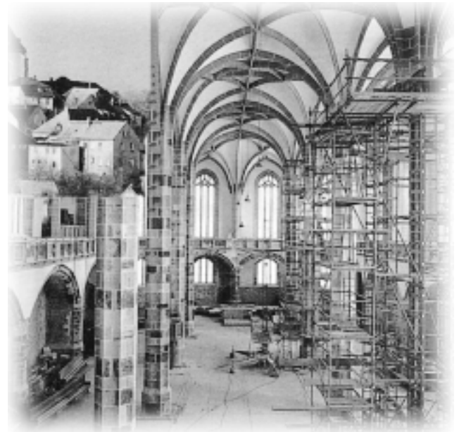
Stützensanierung – Auswechslung der tragenden Konstruktion, Bauzeit 1991–1995
