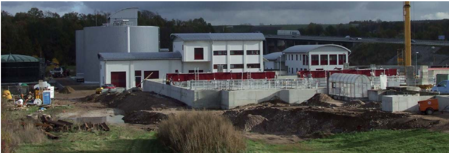
Bauzustand im November 2006.
