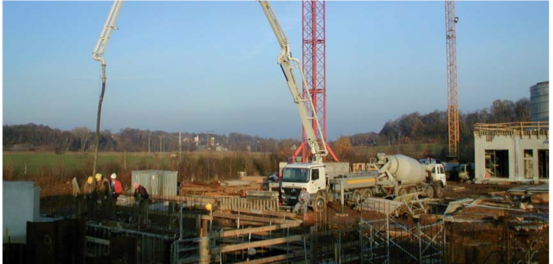
Betonierarbeiten für die Errichtung der Vorklärbecken im Herbst 2005.
