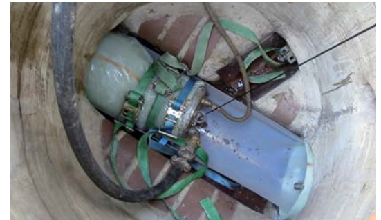
Moderne Leitungsrenovation mit dem Re-Lining-Verfahren im Bereich Schaftriede in Niederwürschnitz. Der zu sanierende Kanalabschnitt wird mit einer Schicht aus Kunstharz ausgekleidet (Foto: IB Dietrich).
