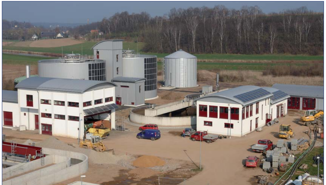
Anlagen zur Klärgasgewinnung und -verwertung, Frühjahr 2007
