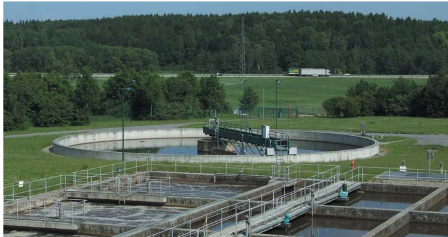
Blick über die Zentrale Kläranlage in Niederdorf mit Belebungs- und Nachklärbecken. Die Behandlungsanlage in Niederdorf besitzt eine Kapazität von 35.000 Einwohnerwerten. Im Hintergrund verläuft die Bundesautobahn A 72.
