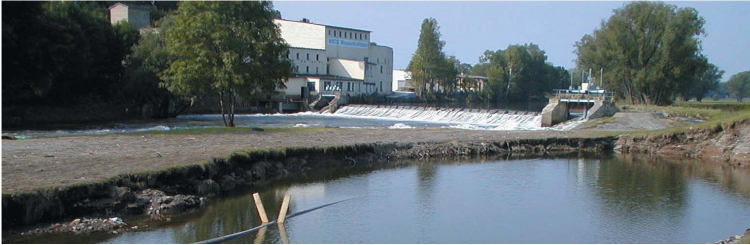
Nach dem Abfließen der Wassermassen wurde das ganze Ausmaß des Wirkens der Naturgewalten ersichtlich, wie hier am Muldenufer in Remse...
