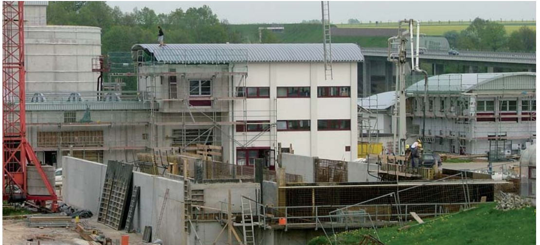
Im April 2006 waren die Arbeiten an den Vorklärbecken bereits weit vorangeschritten.
