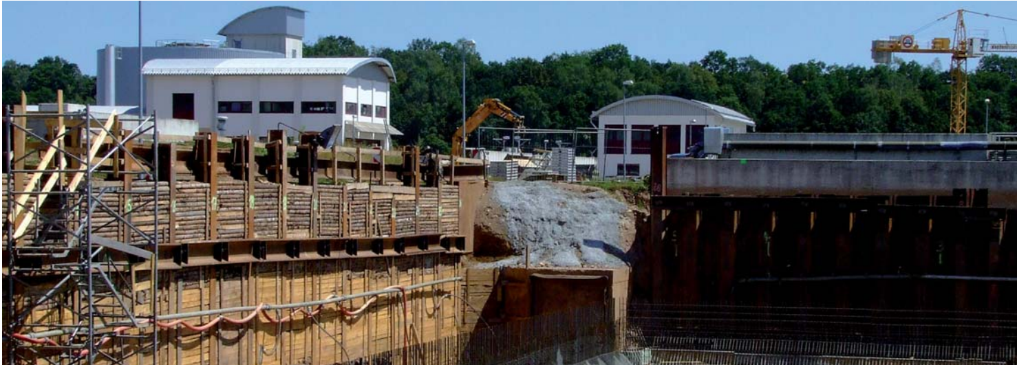
Im Sommer 2006 wurden die Belebungsbecken betoniert.
