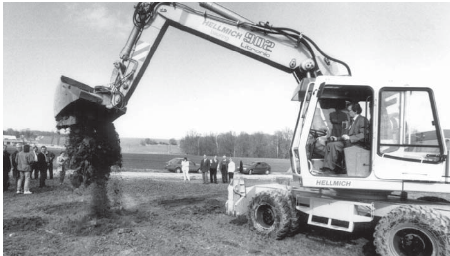
Mit dem symbolischen ersten Spatenstich im März 1994 erfolgte der Start zum Bau der ZKA Weidendorf. Vor den eigentlichen Bauarbeiten galt es die Erschließung des Standorts durchzuführen.
