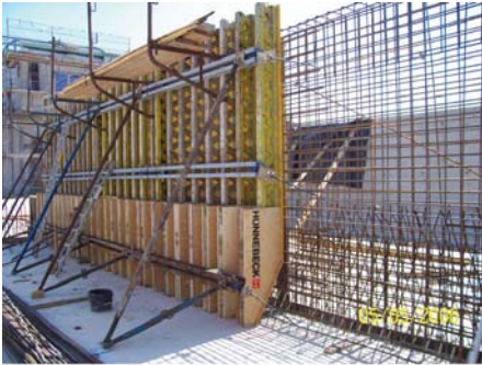
ZKA Glauchau – Weidensdorf Vorklärbecken, Wand
