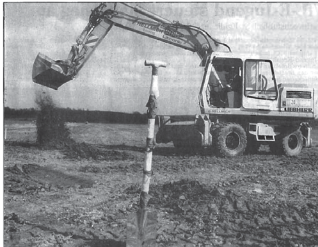
Der Vorsitzende des Abwasserzweckverbandes Glauchau-Lungwitztal, Karl Otto Stetter, stieg gestern nachmittag höchst selbst in den Bagger, um den ersten Spatenstich für die Abwasserbehandlungsanlage Glauchau-Weidensdorf vorzunehmen. Das Projekt kostet 120 Millionen Mark.
