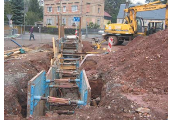
Ein Schwerpunkt des Investitionsgeschehens bildete im Jahr 2006 neben dem Lungwitzalsammler der Kanalbau in der Gemeinde Gersdorf.
