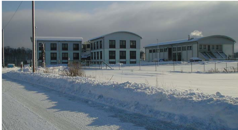
Ansicht der Zentralen Kläranlage Weidendorf im Winter 2002.
