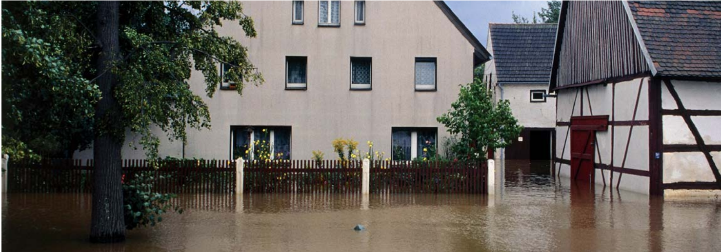
Vom Hochwasser im August 2002 wurde auch die Region Westsachsen in Mitleidenschaft gezogen. Dank des unermüdelichen Einsatzes unserer Mitarbeiter konnte der störungsfreie Betrieb der Zentralen Kläranlage Weidendorf gesichert werden. Das Bild zeigt die Überschwemmung im Glauchauer Ortsteil Jerisau (Foto: Karsten Henschel).
