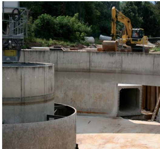
Umbau der Kläranlage Lichtenstein zu einem RÜB.
