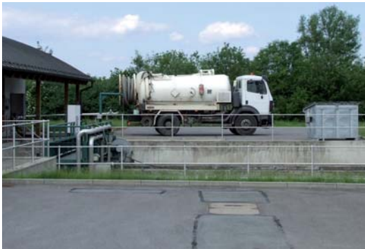
Die Entsorgung von Fäkalien und fäkalhaltigem Abwasser erfolgt in Weidensdorf und Niederdorf. Das Bild zeigt die Fäkalannahme auf der Zentralen Kläranlage Niederdorf. Die Anlieferung der Fäkalien erfolgt durch beauftragte Transportunternehmen.
