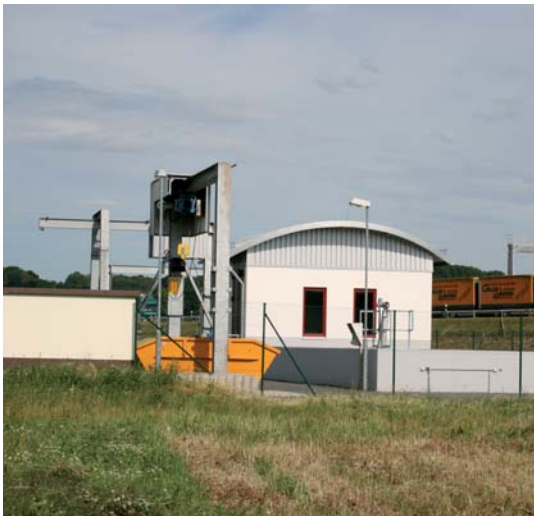
Im Verlauf des Lungwitzalsammlers wurden drei Pumpwerke errichtet.
