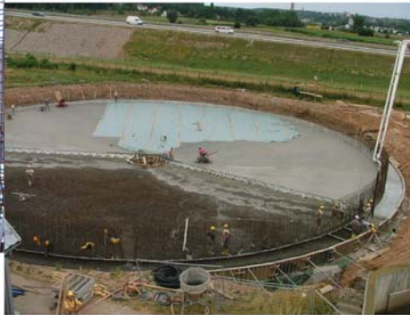
ZKA Glauchau – Weidensdorf Nachklärbecken, Bodenplatte
