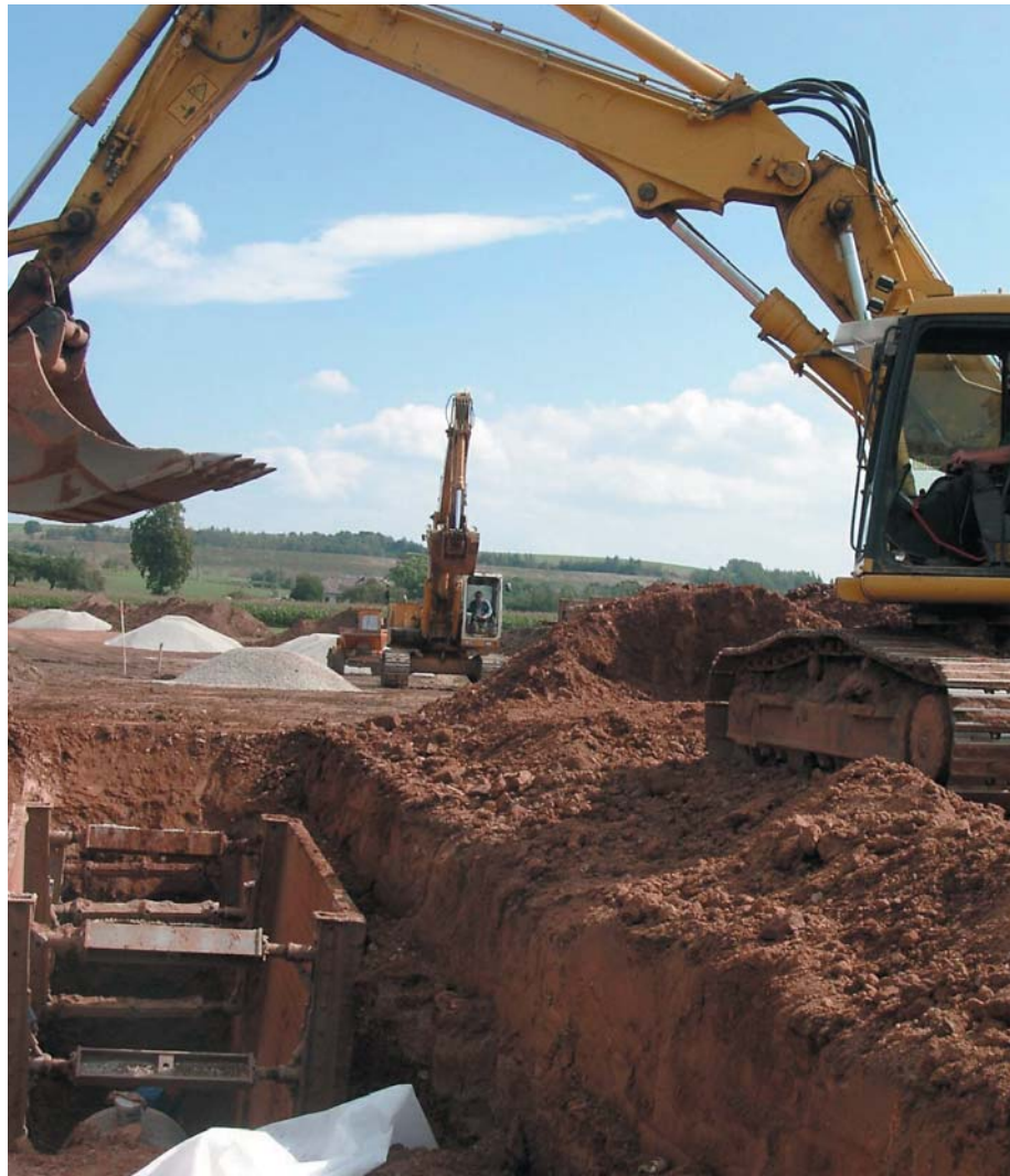
Bauabschnitt 3.1 des Lungwitzalsammlers in St. Egidien, Sommer 2004.
