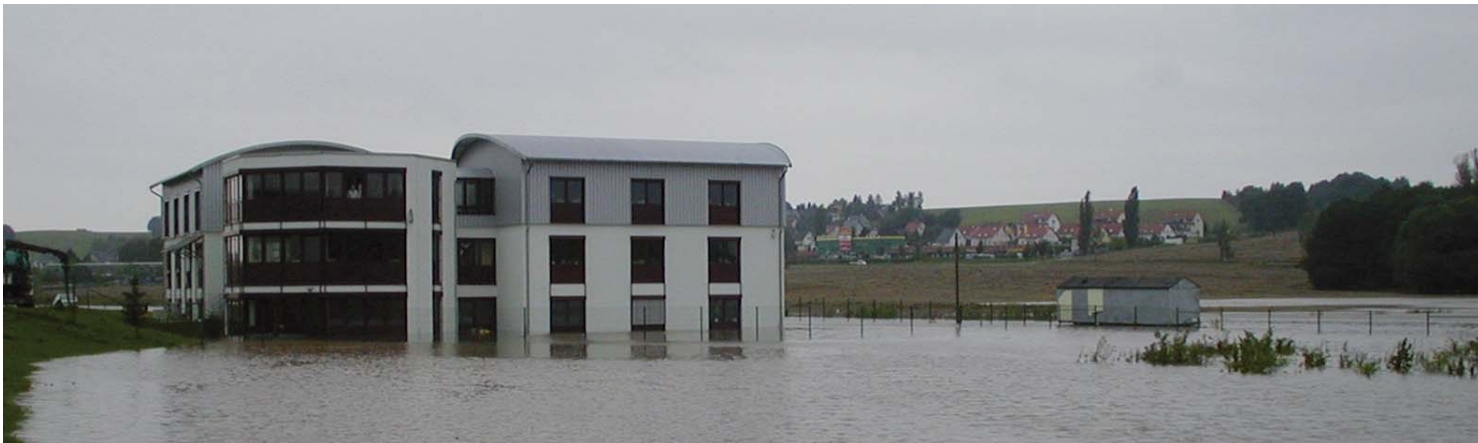
In den Verwaltungs- und Technikgebäuden standen die Kellergeschosse bis zur Decke im Muldenwasser. Die Wiederherstellung dieser Räume nahm einige Wochen in Anspruch.
