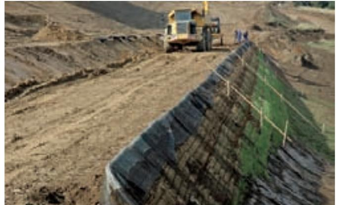
Abbildung 4: Herstellung des Straßendamms als bewehrte Erdekonstruktion bei Bau-km 4+800
