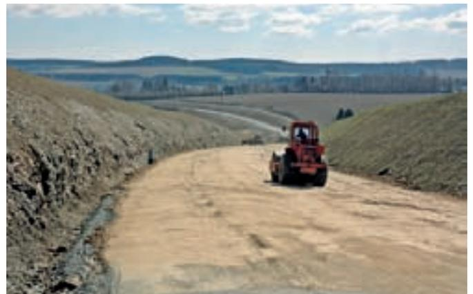
Abbildung 5: Herstellung des Erdplanums bei Bau-km 3+100
