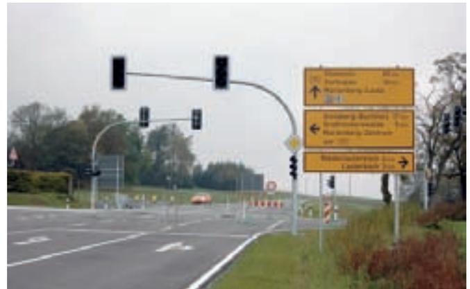
Abbildung 28: Knotenpunkt 2 mit installierter Lichtzeichenanlage
