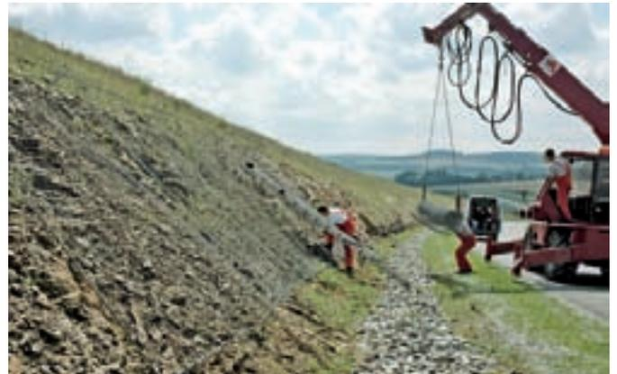
Abbildung 23: Verlegung von Steinschlagschutznetzen
