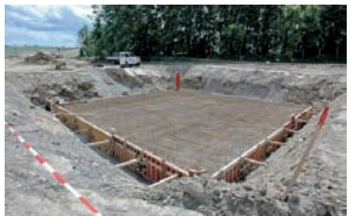
Abbildung 24: Stahlbetonplatte, Gefährdungsbereich 26
