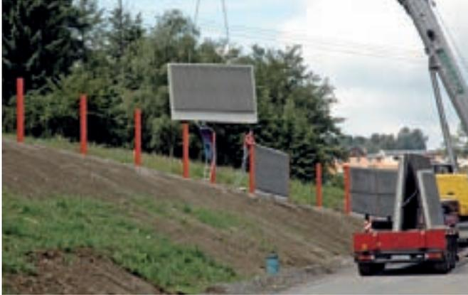
Abbildung 25: Montage von Lärmschutzwandelementen
