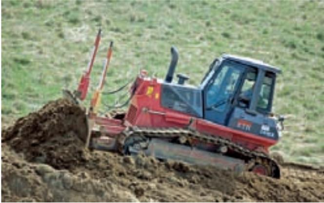
Abbildung 1: Abschieben von Oberboden durch eine Planierraupe
