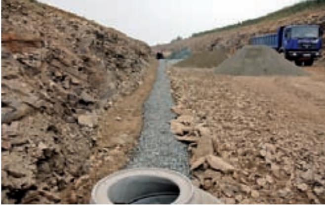
Abbildung 6: Sickerstrang bei Bau-km 3+200
