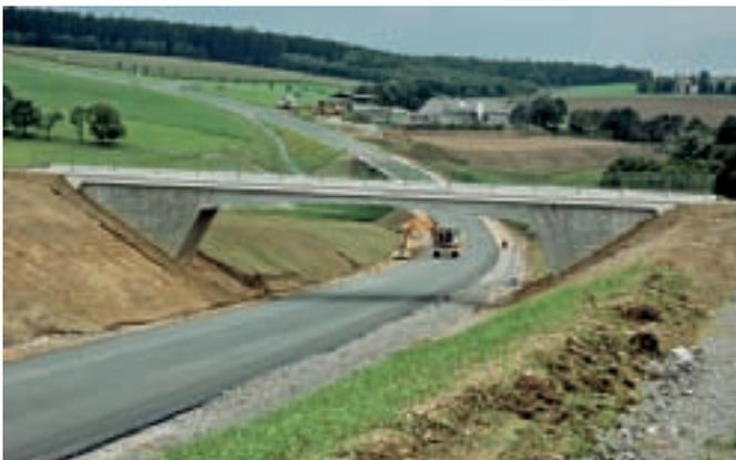
Abbildung 21: Stahlbetonrahmenbrücke, Bauwerk 9
