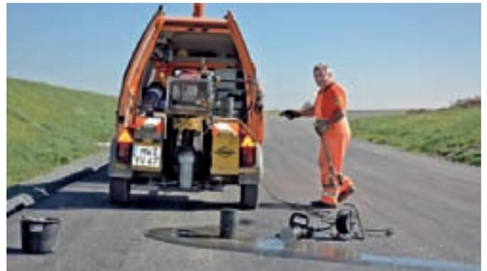
Abbildung 15: Entnahme von Asphaltproben durch Kernbohrungen
