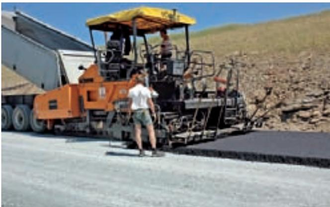
Abbildung 12: Straßenfertiger bei der Herstellung von 10 cm Asphalttragschicht bei Bau-km 3+ 200
