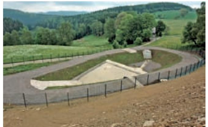
Abbildung 10: Regenrückhaltebecken (RRB 4)
