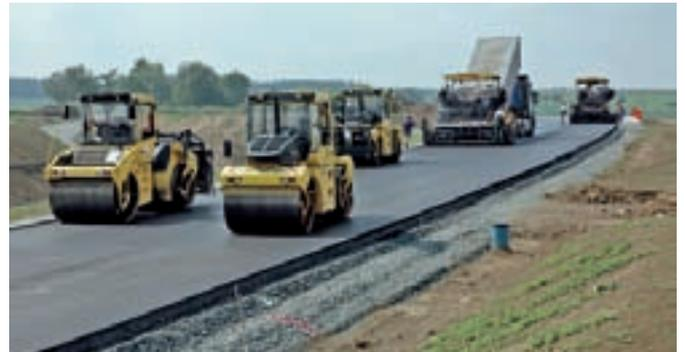
Abbildung 14: Asphalteinbaukomplex bei der Herstellung der 4 cm Asphaltdeckschicht aus Splittmastixasphalt 0/11 S
