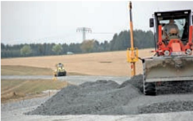
Abbildung 11: Einbau der Schottertragschicht bei Bau-km 2+300
