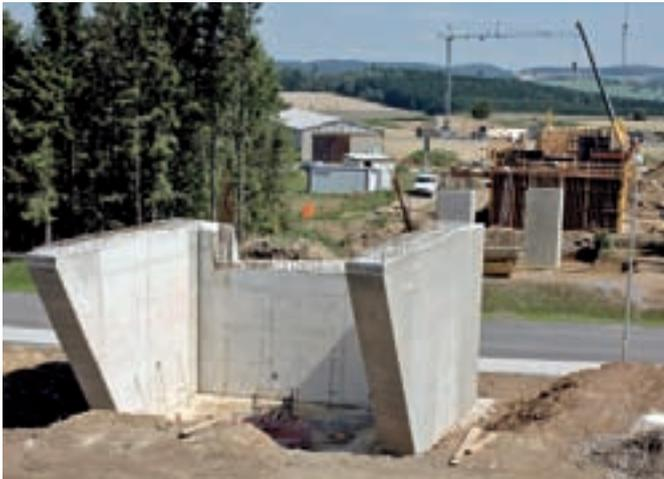
Abbildung 20: Widerlager und Pfeiler des Bauwerks 8
