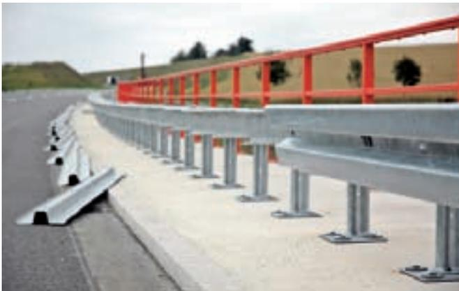
Abbildung 26: Schutzplankenmontage auf Bauwerk 3
