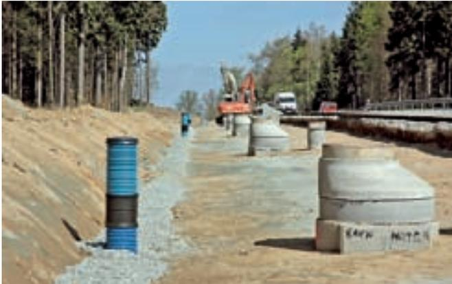
Abbildung 7: Sickerstrang mit Kontrollschächten bei Bau-km 9+600
