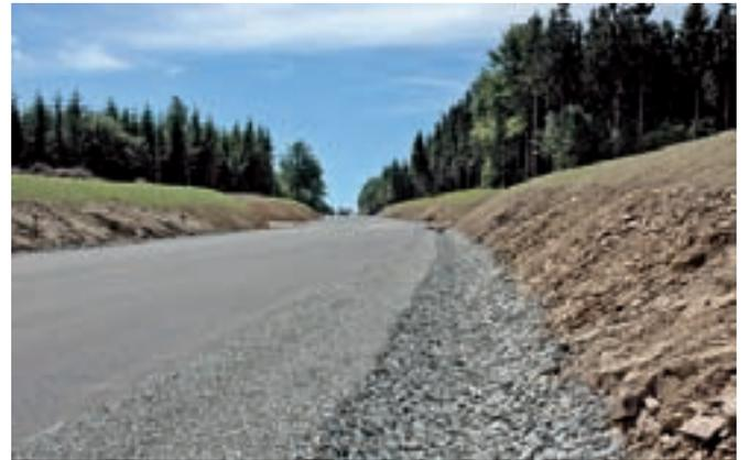
Abbildung 9: Fahrbahn, Bankette und Entwässerungsmulde bei Bau-km 8+900
