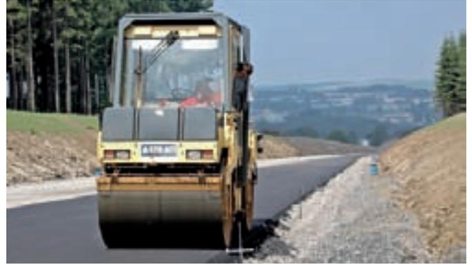
Abbildung 13: Tandemvibrationswalze
