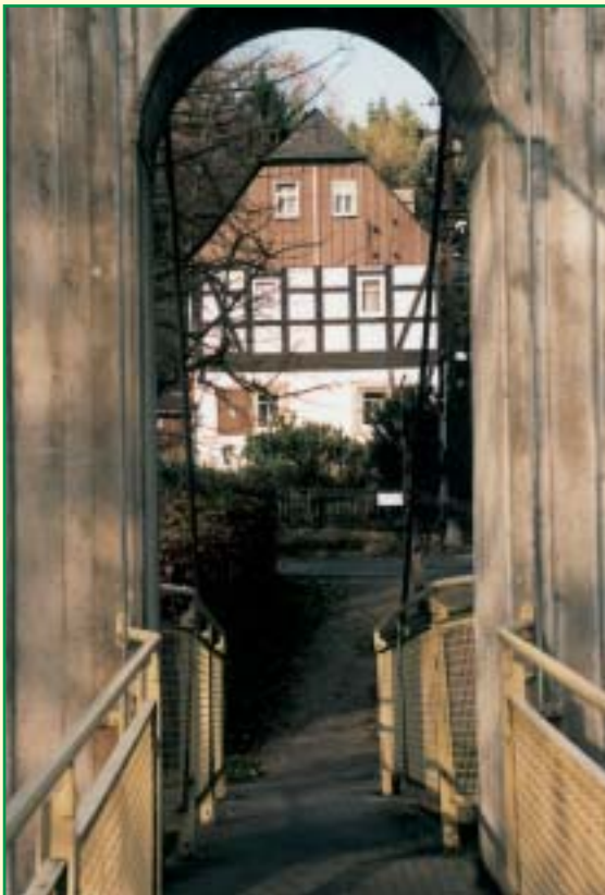
Schaukelbrücke Wolkenburg mit Fachwerkhaus
