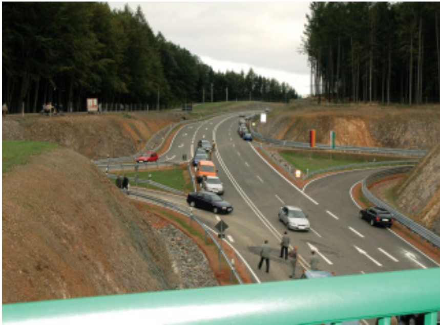
Ortsumgehung B 180 Stollberg kurz vor der feierlichen Freigabe
